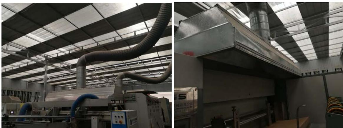
图 4-3 印刷机上方集气罩
