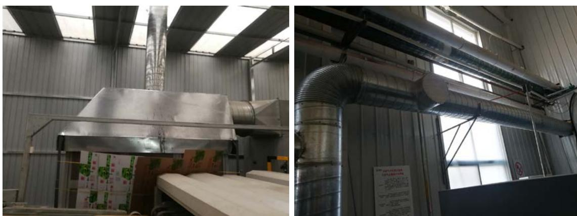
图 4-4 印刷机上方集气罩和连接风管
