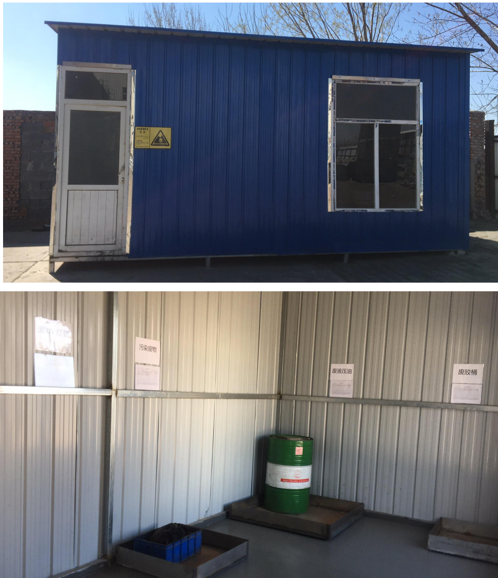
图 2-1 厂区内危废暂存间
